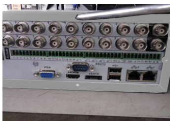
①拆卸主机上盖的固定螺丝
