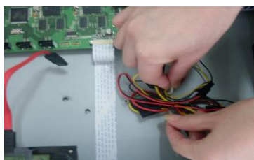
⑦解开硬盘录像机内部的硬盘电源线
